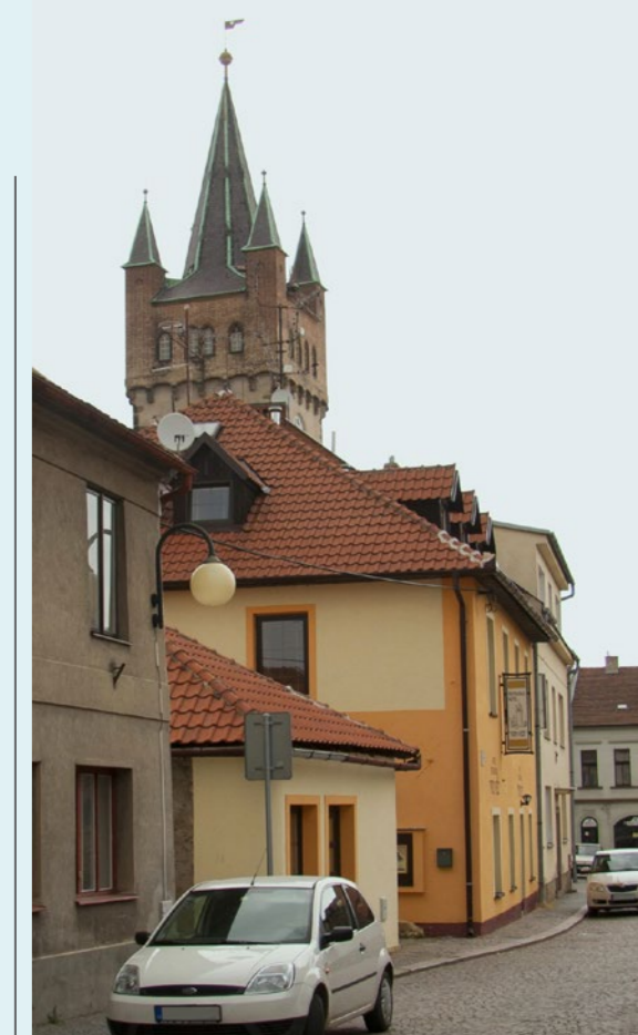
Současný pohled na budovu první dílny
