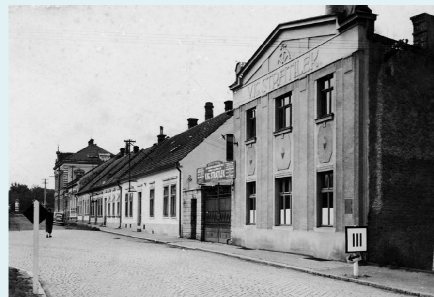
Nové tovární prostory v Riegrově ulici používané od roku 1910
